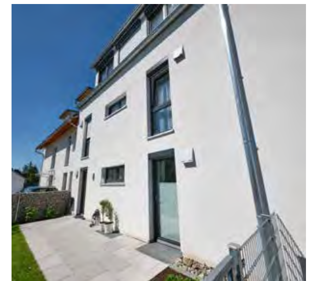
In 2020 wurden somit insgesamt 15 Neubauwohnungen in die Bestandsbewirtschaftung aufgenommen.
