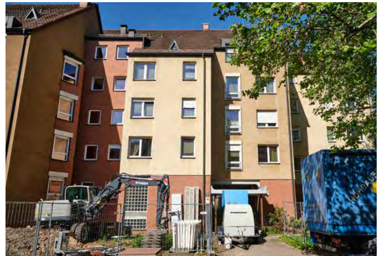
Sanierung Wohnanlage Stresemannplatz
