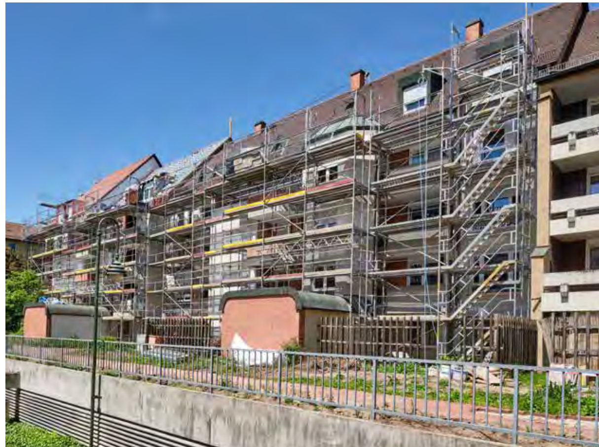
Sanierung Wohnanlage Stresemannplatz
