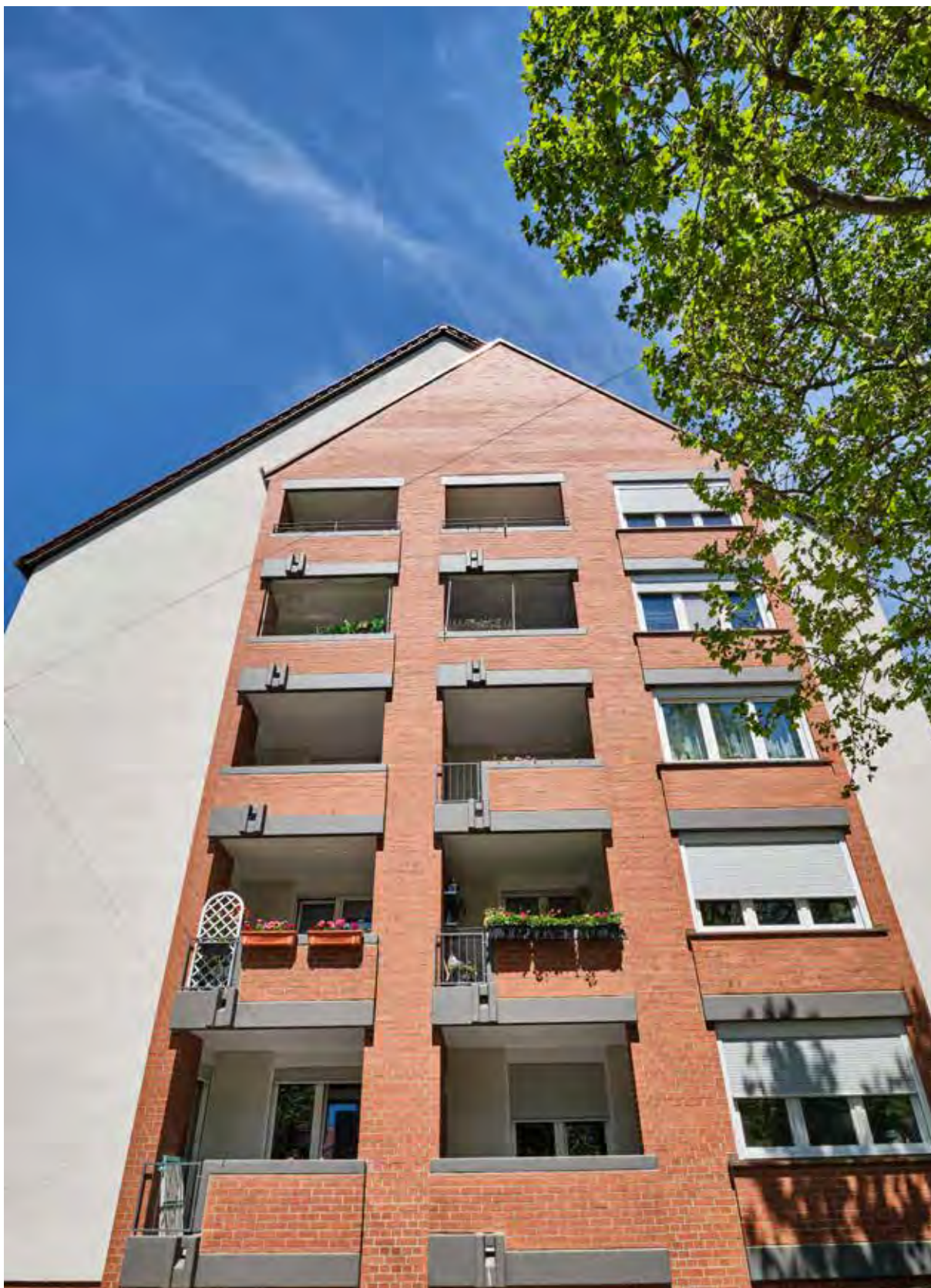
Sanierung Wohnanlage Stresemannplatz
