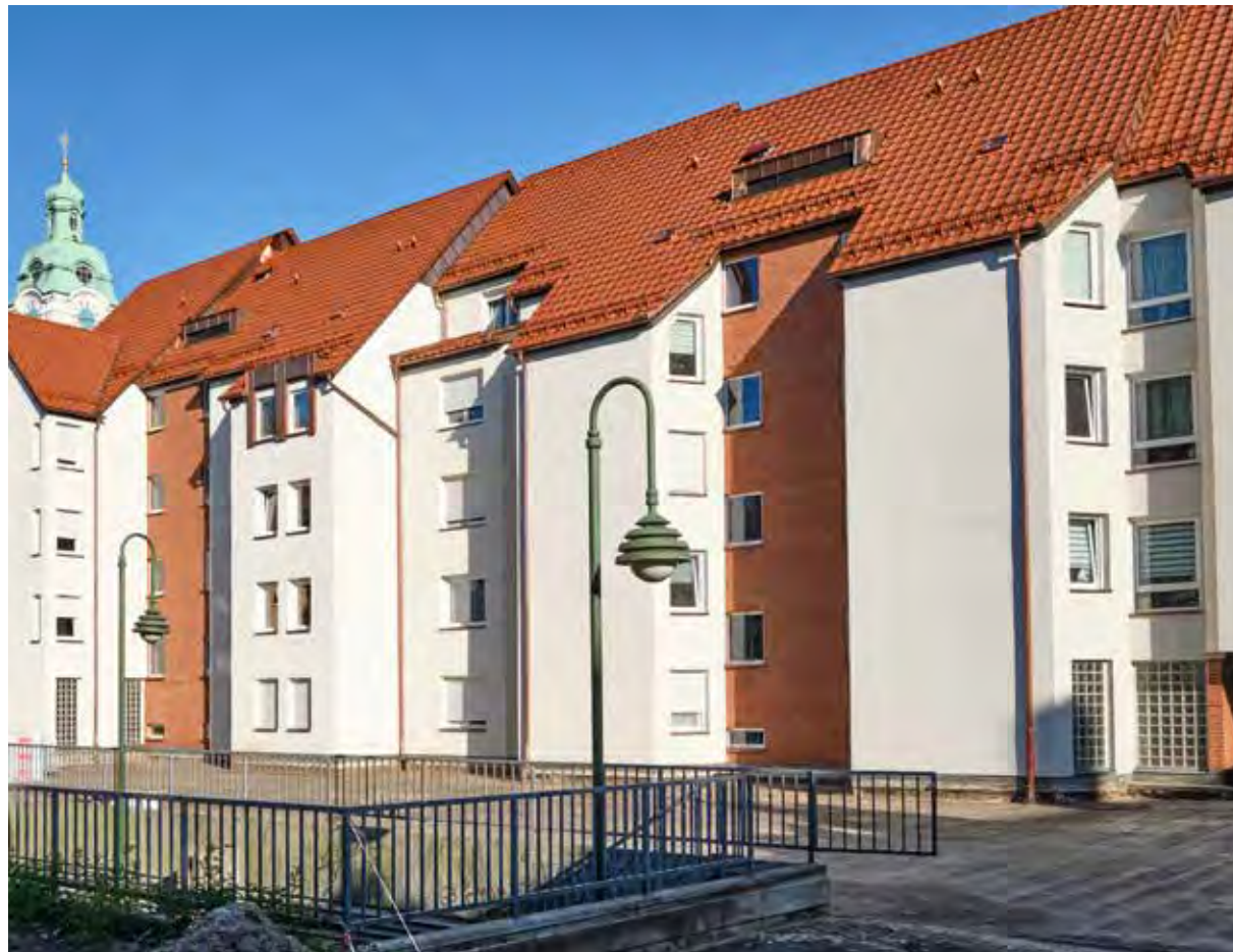
Sanierung Wohnanlage Stresemannplatz
