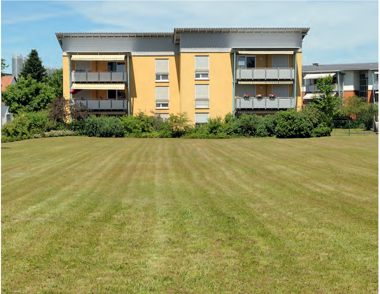
Nelkenweg 32 (vorne Baufeld für 2. Abschnitt)
