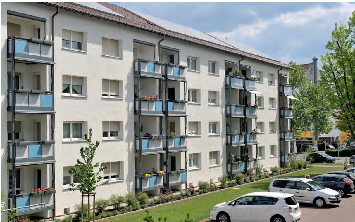
ARGE GmbH- Modernisierung Soldnerstraße 89-91-93
