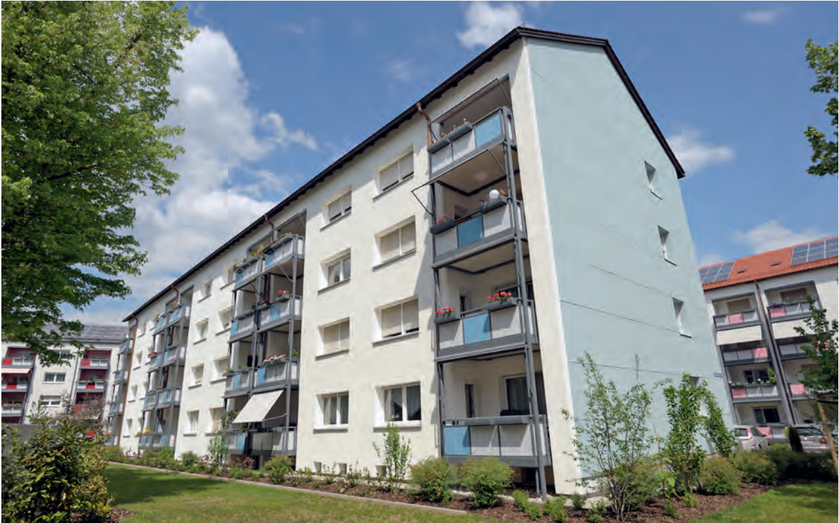
ARGE GmbH- Modernisierung Soldnerstraße 89-91-93
